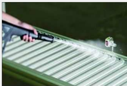
設備の高圧水洗浄
